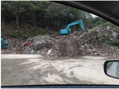
山積みされた廃材の撤去作業
